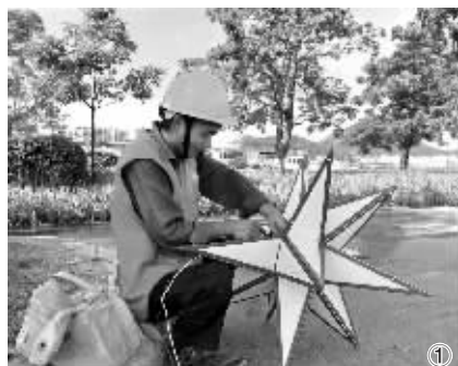
①工人为LED节能景观灯接线 ②工人在广场上安装LED节能景观灯 ③工人为“东方明珠”装上LED节能灯
